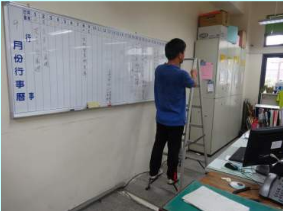
模擬受傷勞工使用合梯情形(當時陳○○為安裝吊掛白板之螺栓)
